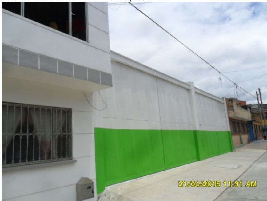
Foto 2. Parte norte de la fachada del predio
